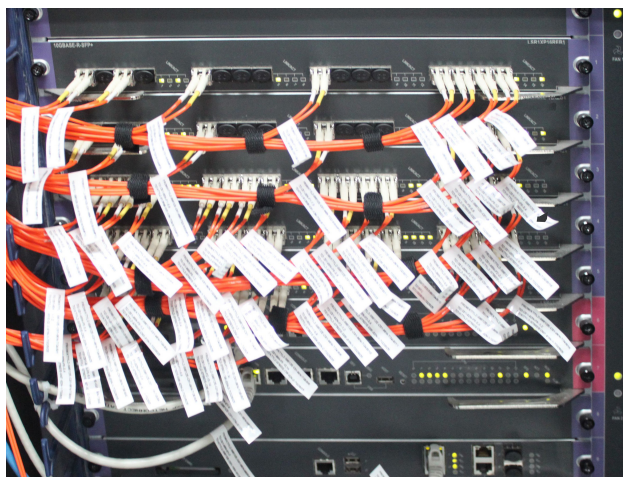
图B-34 光纤的布放与绑扎示意图
