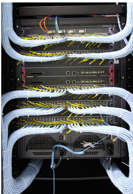
图B-33 网线的布放与绑扎示意图
